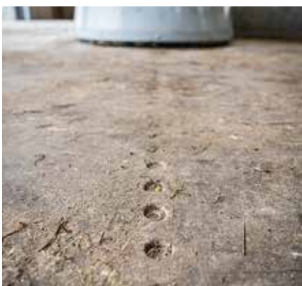
Magnesy wbudowane w podłogę są niezbędne tylko przed stacją ładowania.
